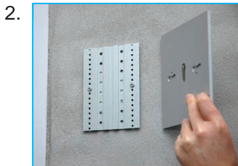
Udfræste nøgle huller sættes på plads over de 2 nitter
