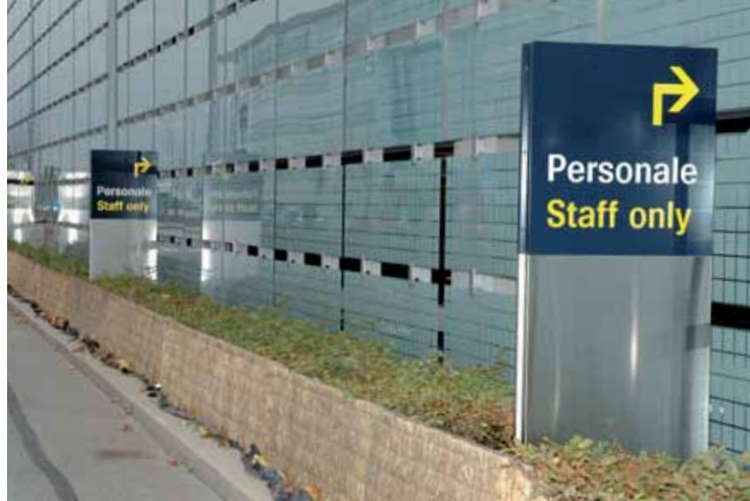
Pyloner ved personaleparkering i Københavns Lufthavn. Materiale: Rustfrit stål. Tekst og pil er udfræset i front og fremstår lysende i mørke.
