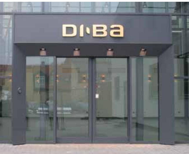
Messing bogstaver med svøb og indvendig belysning
