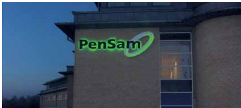
Logo og tekst i aluminium med indbygget diode belysning
